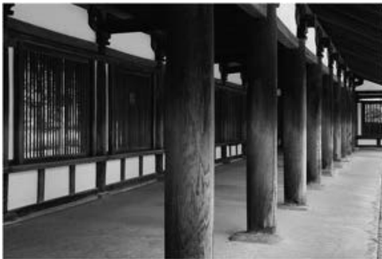
[写真Ⅱ] 日本・法隆寺の柱 (約1400年前に建造)
